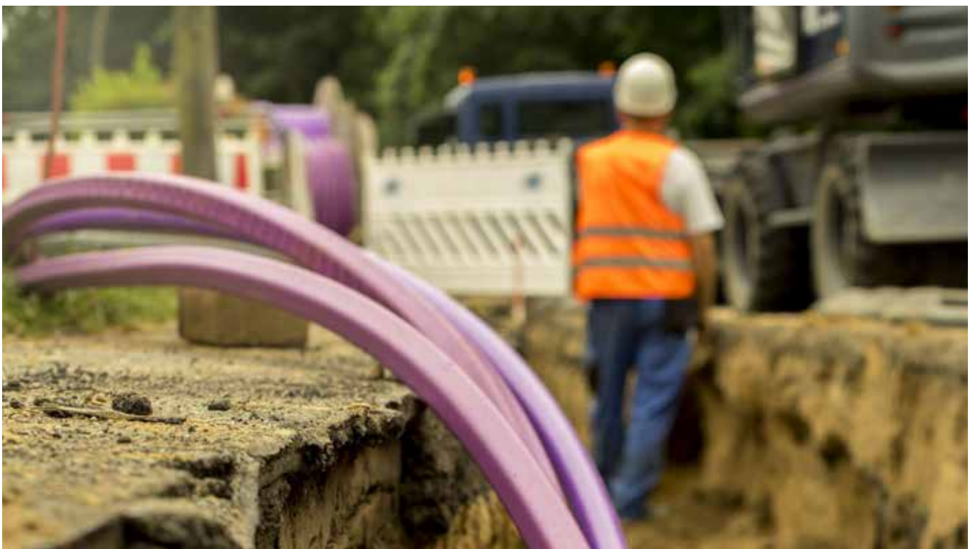
Instalação de uma rede de fibra ótica — um grande investimento na infraestrutura regional de França.
